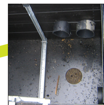
Podzielna w pionie, profil z narożnym łącznikiem, otwór drenażowy w płycie dolnej
