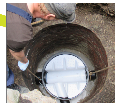
Posadowienie nowej kinety w studni
