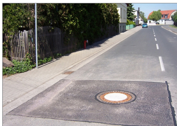
Odtworzenie nawierzchni drogi
