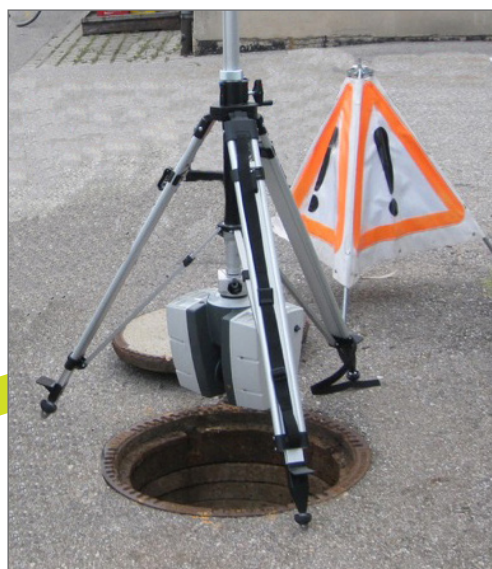
Szczegółowy pomiar istniejącej studni
