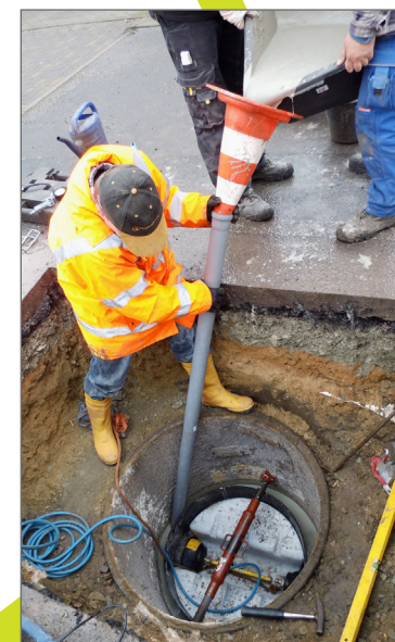
Wypełnienie luki między studniami
