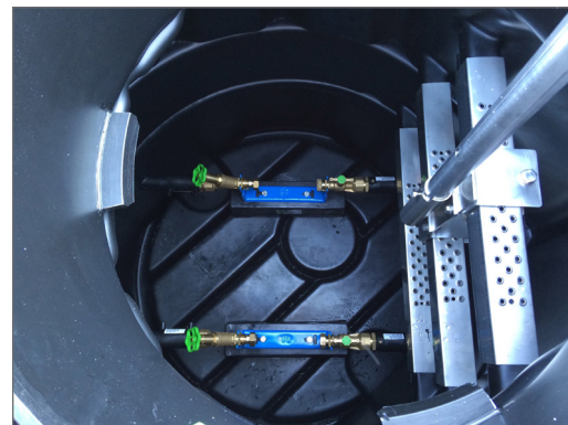
Studnia wodomierzowa ze zintegrowanym zestawem instalacyjnym
