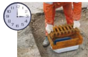
15. Min.: Aufsatz aufsetzen
