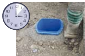
7. Min.: Verfüllen und Verdichten
