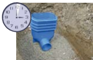
3. Min.: Schacht auf Mager- beton setzen
