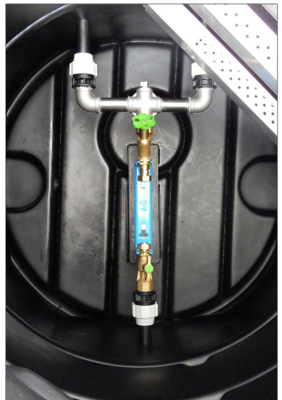
Wasserzähler mit nachfolgender Verteilung
