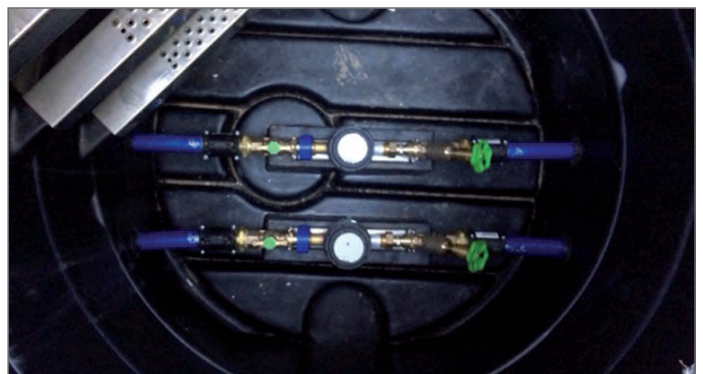
Doppelwasserzählerschacht
