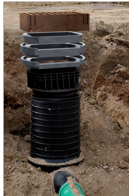
Nachträglicher Höhenausgleich mittels ROMOLD Kunststoff Ausgleichsringe PDRD
