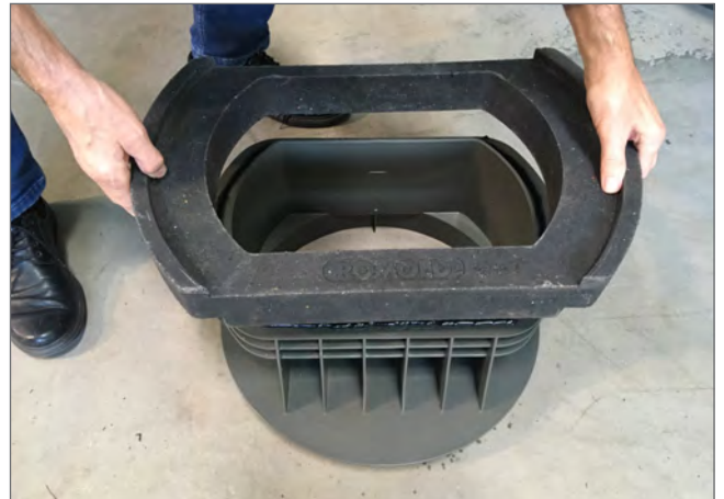
PDRD 50.30/xx VS in Kleber drücken
