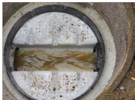
Schacht-in-Schacht Sanierung
