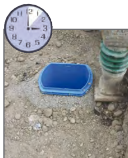
7. Minute: Verfüllen und verdichten
