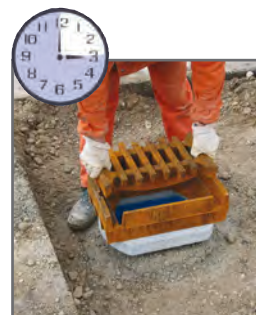
15. Minute: Aufsatz aufsetzen
