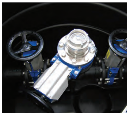
Spülschacht DN 1000 mit 3 Schieber
