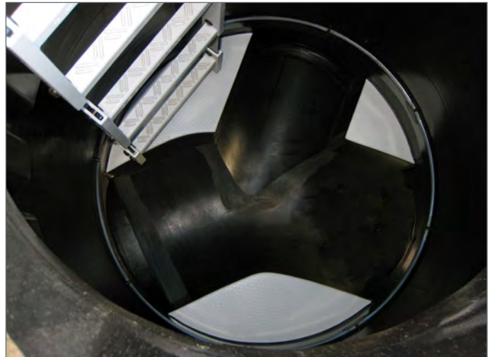
Schacht DN 1000 Gerinne DN 500 + seidl. Zulauf DN 400
