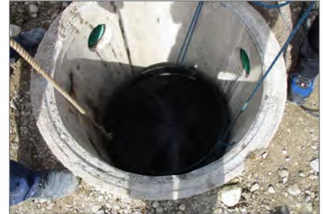
5.) Vorgefertigtes Gerinne mit PE-Stützen in Schachtboden einbringen
