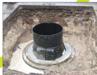
Verfüllen des Zwischenraums zwischen PE-Schacht DN 800 und Betonschacht DN 1000 mit Verfüllmörtel
