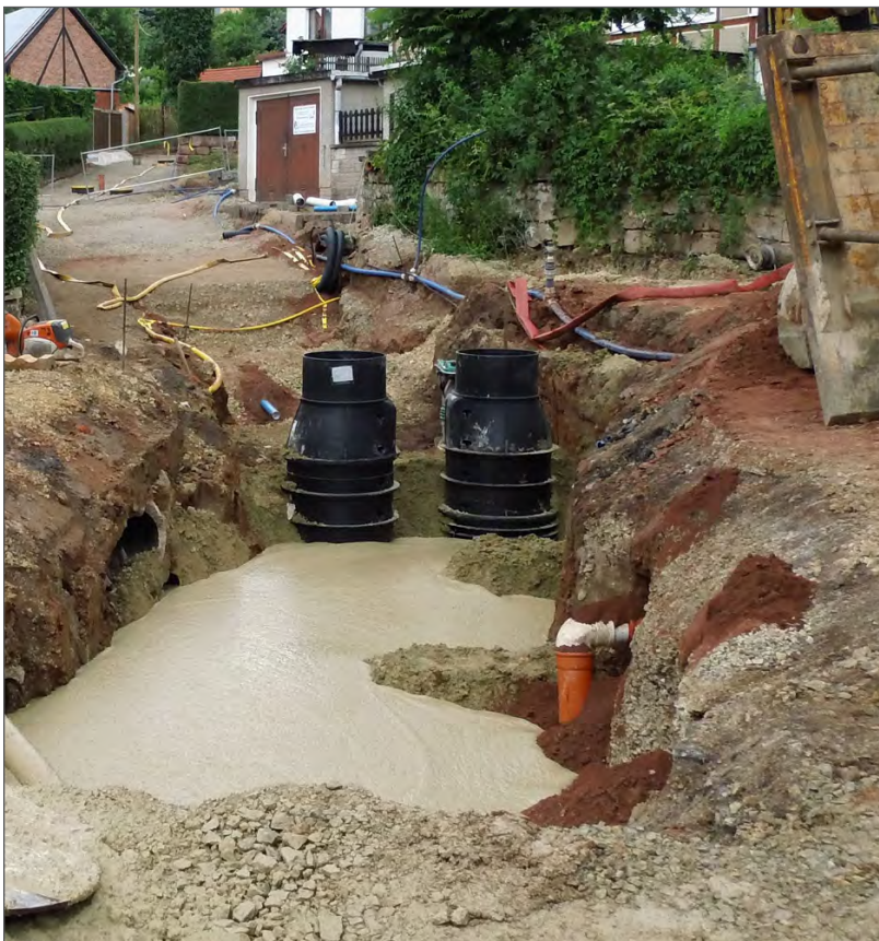
Schachteinbau in Flüssigboden
