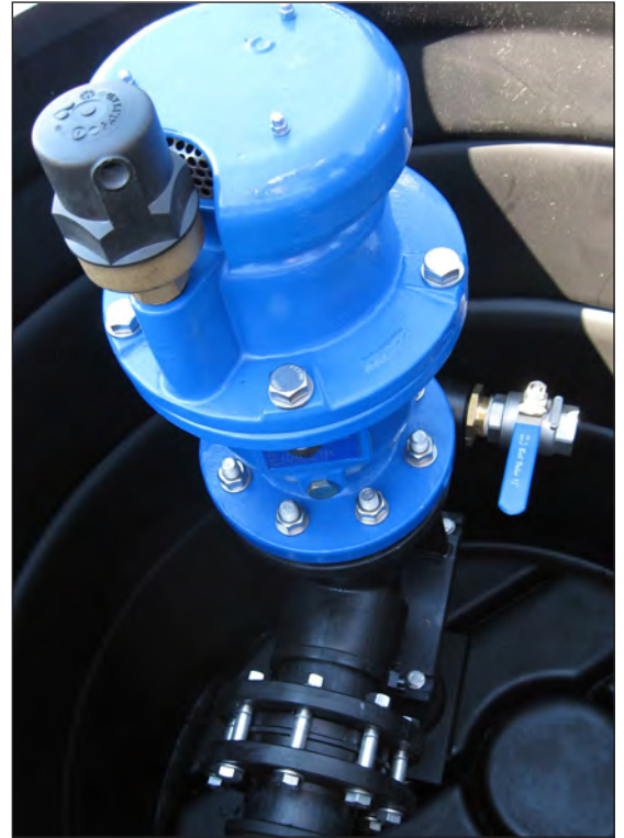
Be- und Entlüftungsventil mit Entleerungsmöglichkeit
