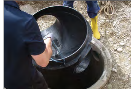
4.) Vorgefertigtes Gerinne mit PE-Stützen anpassen (Stützen auf Länge kürzen)
