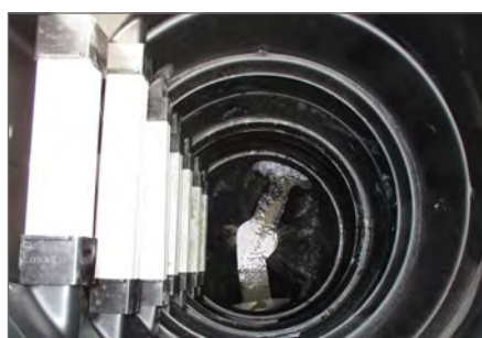
12.) Fertig sanierter Schacht. Steigstufen können auf Kundenwunsch nachträglich entfernt werden
