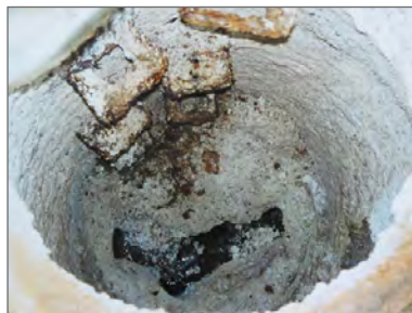
Ausgangssituation: korrodierter Betonschacht
