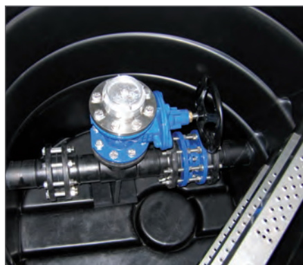
Spülschacht DN 1000 mit 1 Schieber
