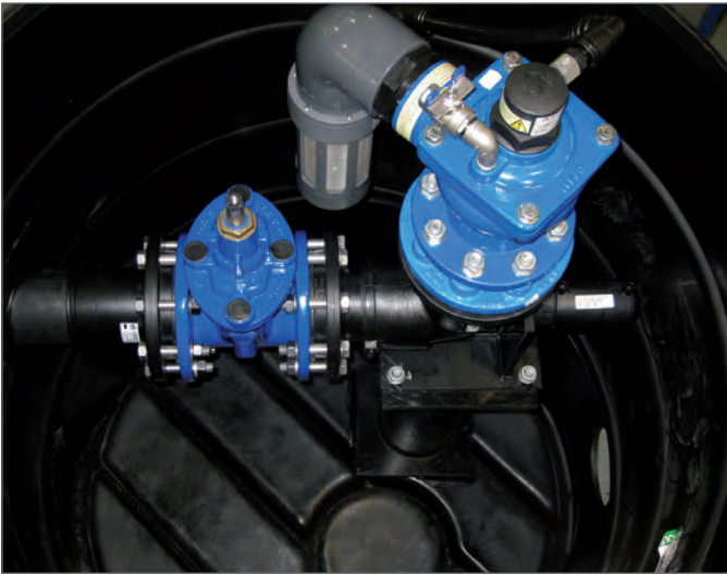
Be- und Entlüftungsschacht mit Rückstausicherung
