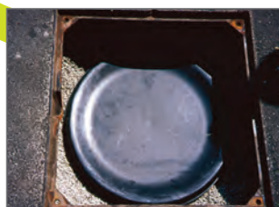
Dichtes Schachtabdeckungssystem mit getrennter Dicht- und Tragfunktion
