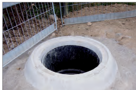
10.) Verfüllen des Zwischenraums. Wiederherstellen des Straßenaufbaus inkl. lastenkoppelter Abdeckung.
