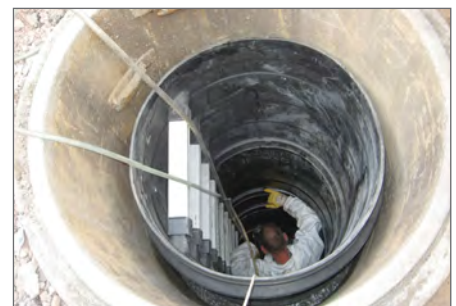
10.) Aufsetzen der Dichtungen und Schachtbauteile PE Schachtsystem DN 800
