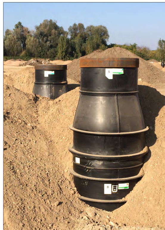
Verzahnung mit dem Erdreich gegen Auf- und Abtrieb
