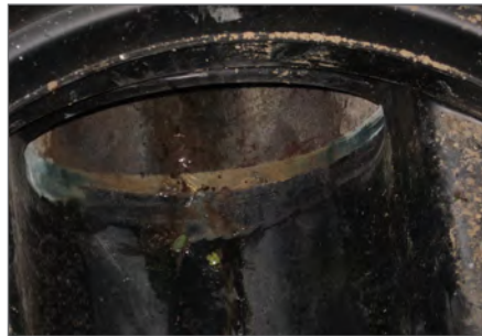
7.) Anbindung der PE-Stützen an das Altrohr erfolgt mit Verfüllmörtel
