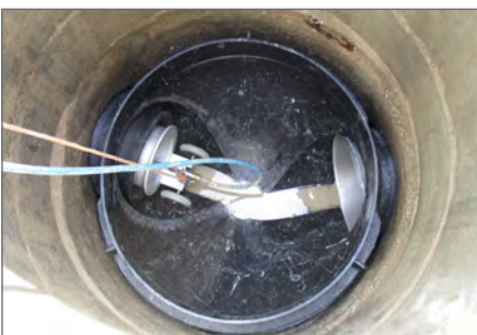
8.) Mannschette (Quick Lock) an Ablauf und Zuläufen setzen, Verfüllen des Zwischenraums mit Verfüllmörtel
