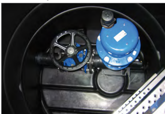
Be- und Entlüftungsschacht als Seitenanschluss
