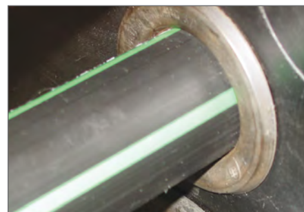
Rohranbindung mit Dichtung 0,5 bar wasserdicht
