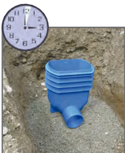
3. Minute: Schacht auf Magerbeton setzen
