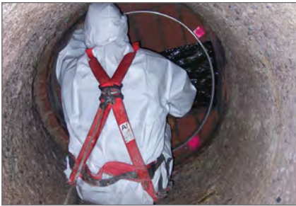
4.) Montagering auf Berme befestigen
