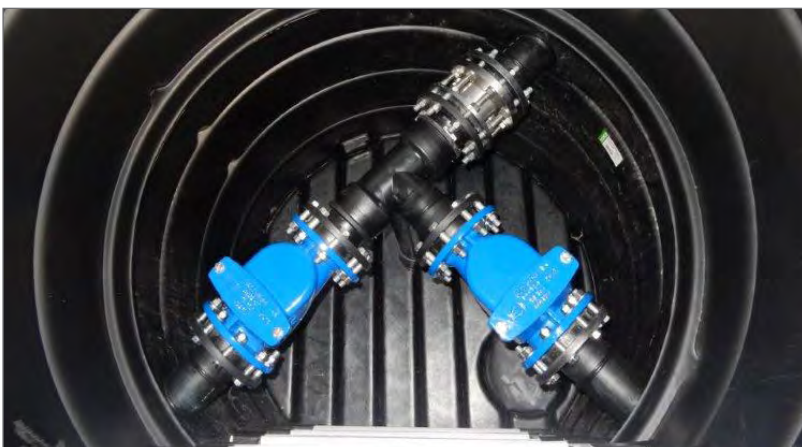
Abzweig mit Rückschlagklappen
