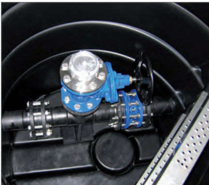
Spülschacht DN 1000 mit 1 Schieber
