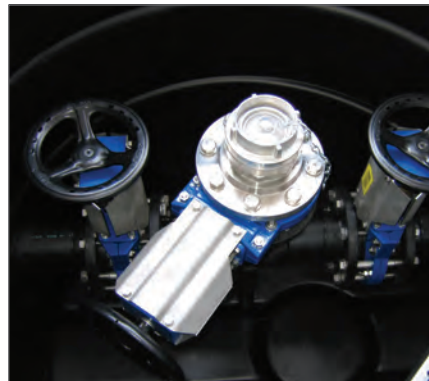
Spülschacht DN 1000 mit 3 Schieber
