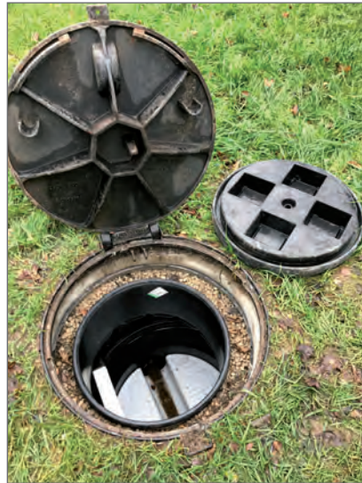
Beispielfoto Gerinneschacht im Überflutungs- bereich
