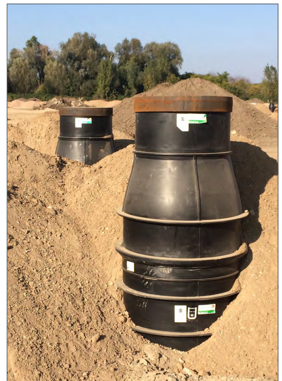
Verzahnung mit dem Erdreich gegen Auf- und Abtrieb
