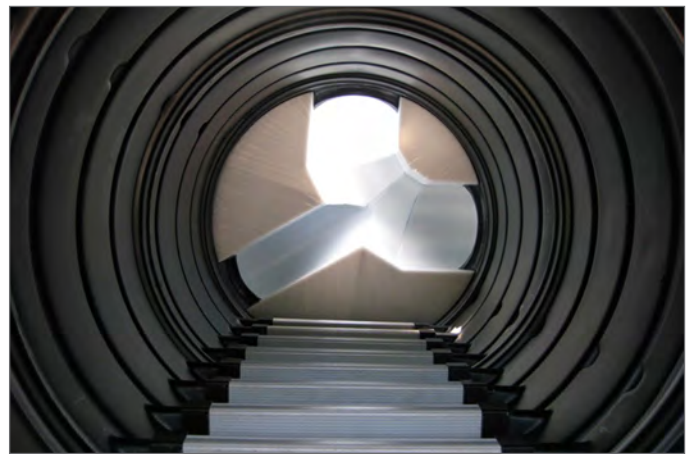
Schacht DN 1250. Abgewinkeltes Gerinne DN 600 mit seitlichem Zulauf.
