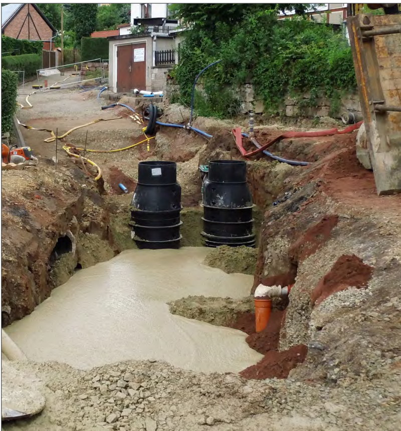
Schachteinbau in Flüssigboden
