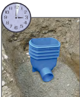
3. Minute: Schacht auf Magerbeton setzen
