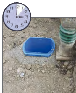
7. Minute: Verfüllen und verdichten
