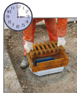
15. Minute: Aufsatz aufsetzen
