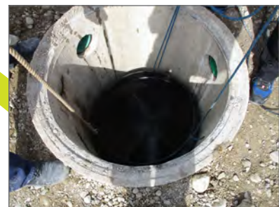
Neuen Boden in den Schacht ablassen
