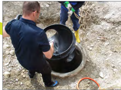
Neuen Boden in den Schacht ablassen
