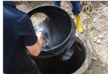
4.) Vorgefertigtes Gerinne mit PE-Stutzen anpassen (Stutzen auf Länge kürzen)
