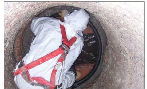
6.) Aufsetzen der ROMOLD Elementdichtung auf Montagering. 100% dichter Übergang auf Schachtbau- bauteile
