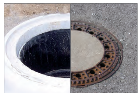
13.) Wiederherstellen des Straßenaufbaus und der Straßenoberfläche inkl. lastenkoppelter Abdeckung
