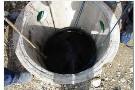
5.) Vorgefertigtes Gerinne mit PE-Stutzen in Schachtboden einbringen
