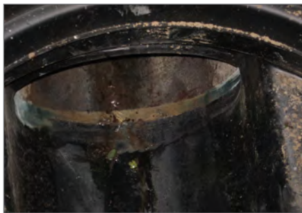
7.) Anbindung der PE-Stutzen an das Altrohr erfolgt mit Verfüllmörtel
