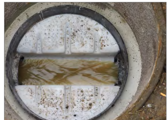
Schacht-in-Schacht Sanierung
