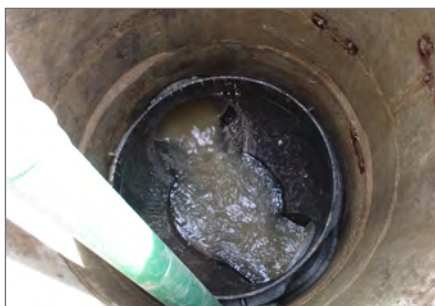
9.) Nach Aushärten des Verfüllmörtels kann die Wasserhaltung abgebaut werden
