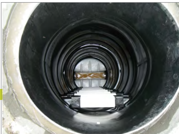
Neuer PE-Schacht DN 800 in korrodiertem Schacht DN 1000
