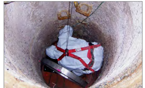
3.) Asphalt aufschneiden, Betonkonus abheben und Steigstufen entfernen
