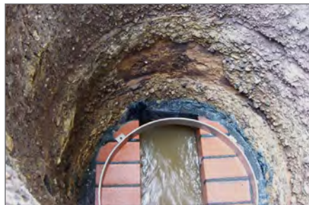
5.) Bild zeigt befestigten Montagering
