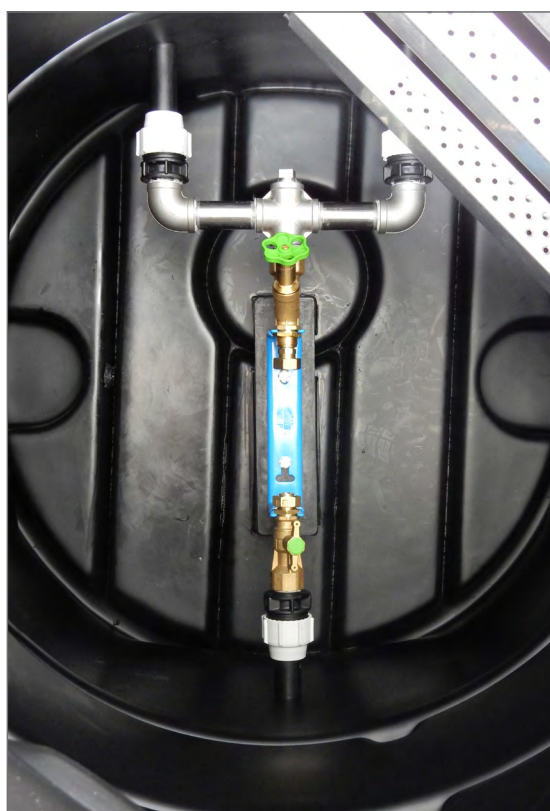
Wasserzähler mit nachfolgender Verteilung
