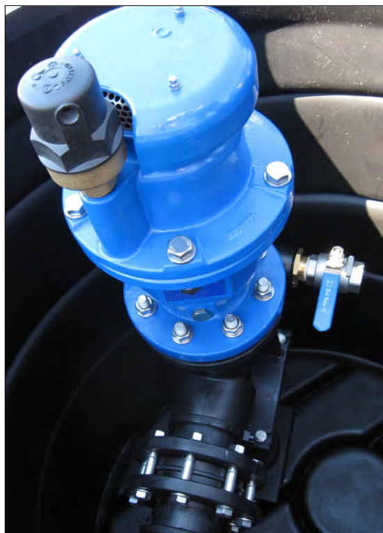
Be- und Entlüftungsventil mit Entleerungsmöglichkeit
