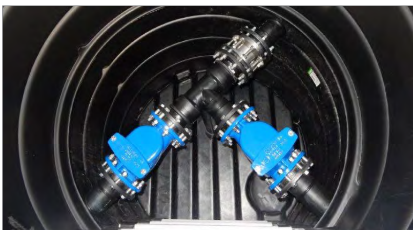
Abzweig mit Rückschlagklappen
