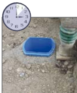
7. minuta: zasypywanie i zagęszczanie
