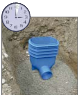
3. minuta: odpływ osadzony w chudym betonie
