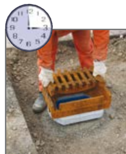
15. minuta: posadowienie kraty wpustowej
