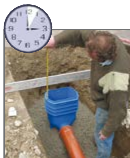
5. minuta: dokładne dopasowanie wysokości
