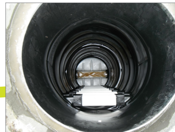
Neuer PE-Schacht DN 800 in korrodiertem Schacht DN 1000
