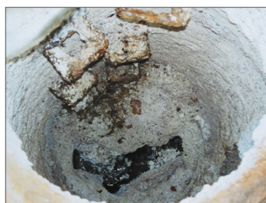
Ausgangssituation: korrodierter Betonschacht
