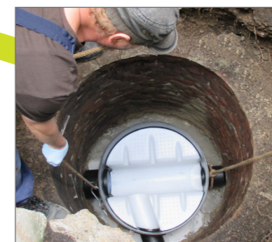
Neuen Boden in den Schacht ablassen
