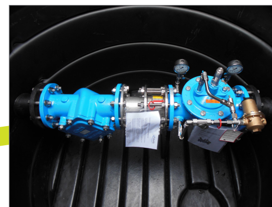
Druckreduzierventilschacht
